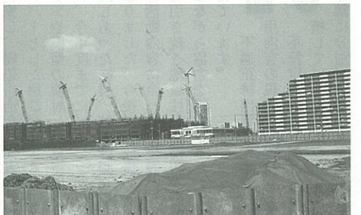
▲第14小学校建築現場(高洲)
