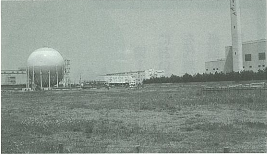
▲斎場建設予定地(千鳥地区)
